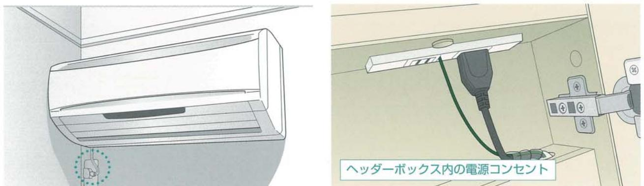
暖房オフシーズンでも、自動的に循環水の循環をする機能があります。室内機から電源を取っているため、室内機、およびヘッダーボックス内のコンセントは抜かないでください。また、ヘッダーボックス内の元栓は締めずに開放したままにしてください。
