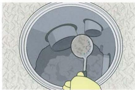
雨水樹の底に沈殿している枯葉や泥、砂などをすくい出します。
